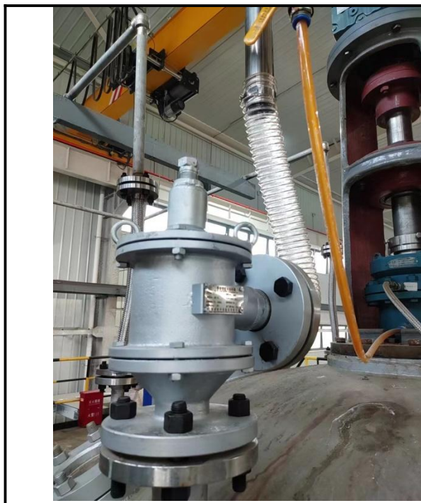
搅拌釜放空口集气管道
