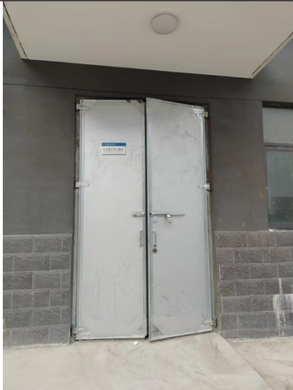
水处理及热交换站外
